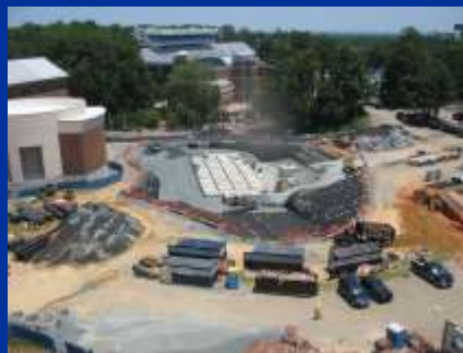
Cistern Gravel Fill
